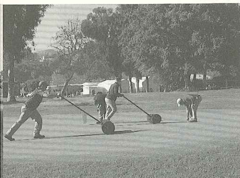
グリーンは硬く、転圧時に若干の修正をするのみ
